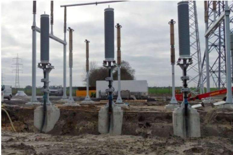
Abb. 2-6: Beispiel Kabelendverschlüsse
