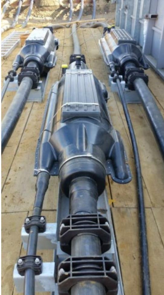
Abb. 2-5: Beispiel für eine Muffenverbindung
