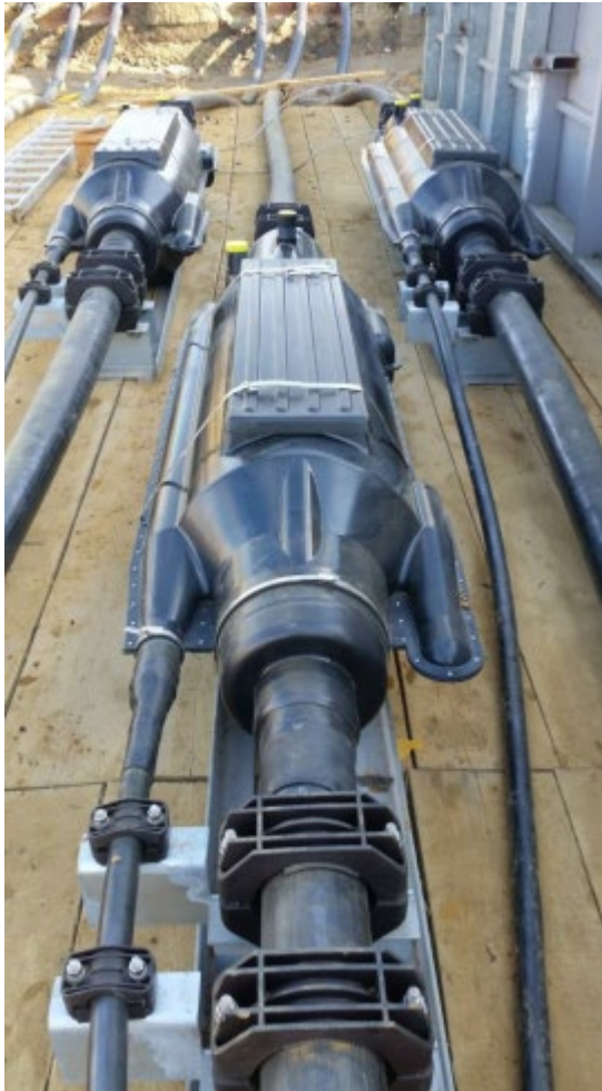
Abb. 2-5: Beispiel für eine Muffenverbindung
