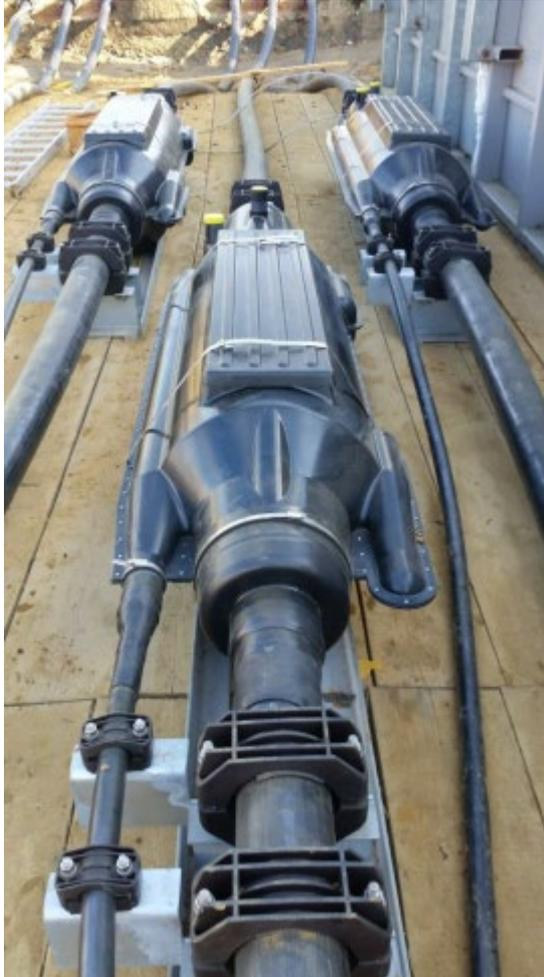
Abb. 2-5: Beispiel für eine Muffenverbindung
