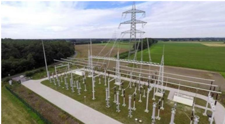
Abb. 2-22: Beispiel einer Kabelübergabestation, Quelle: Amprion GmbH
