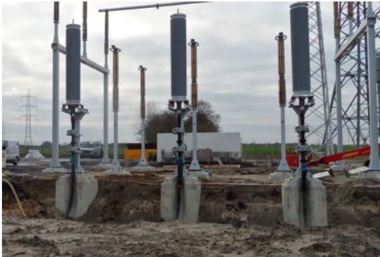
Abb. 2-7: Beispiel Kabelendverschlüsse
