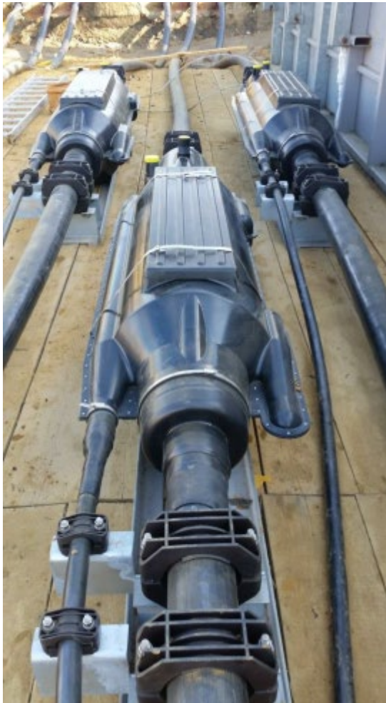
Abb. 2-6: Beispiel für eine Muffenverbindung
