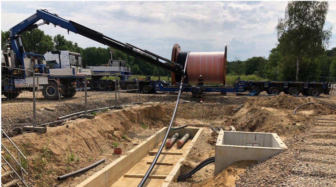
Abb. 2-22: Beispiel für den Kabelzug am Spulenplatz, Quelle: Amprion GmbH
