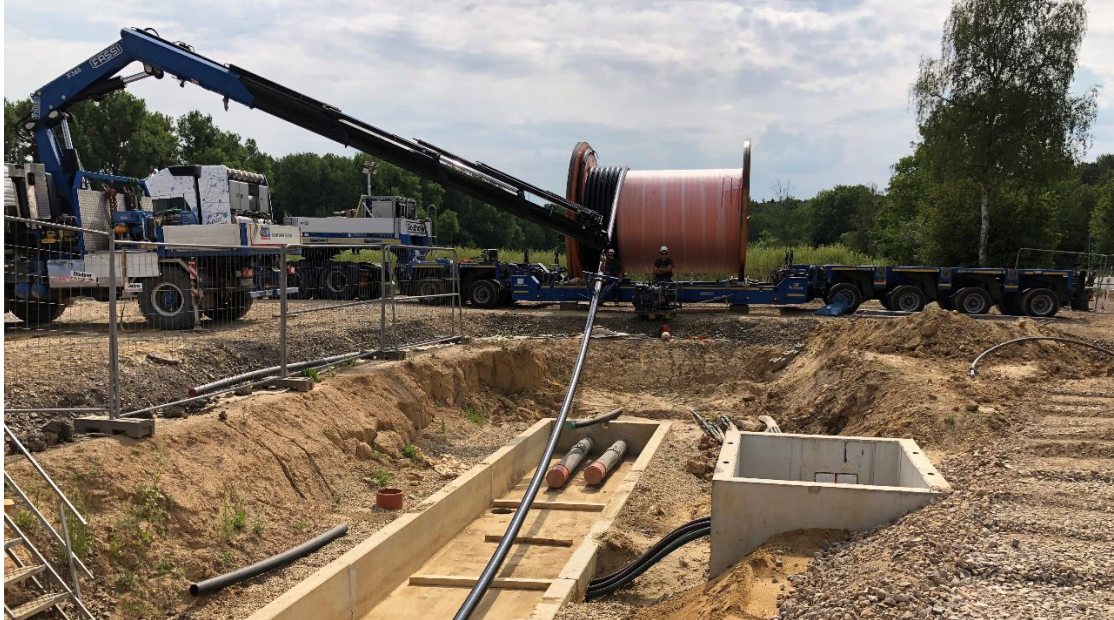
Abb. 2-19: Beispiel für den Kabelzug am Spulenplatz, Quelle: Amprion GmbH
