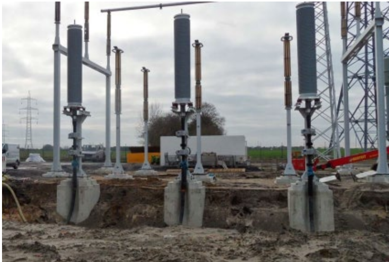
Abb. 2-6: Beispiel Kabelendverschlüsse
