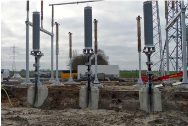
Abb. 2-7: Beispiel Kabelendverschlüsse
