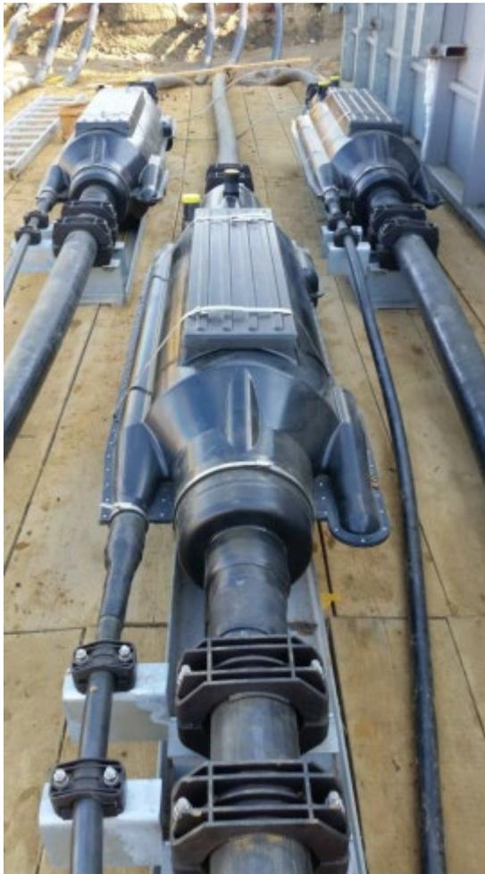
Abb. 2-6: Beispiel für eine Muffenverbindung
