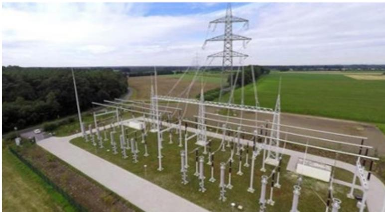
Abb. 2-25: Beispiel einer Kabelübergabestation, Quelle: Amprion GmbH
